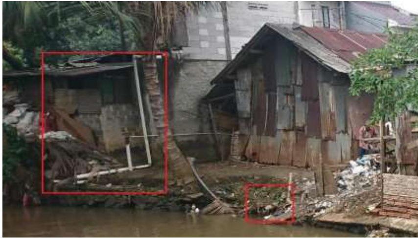
Gambar 9. Sistem pembuangan limbah langsung ke sungai pada rumah semi permanen di lokasi TP 5
