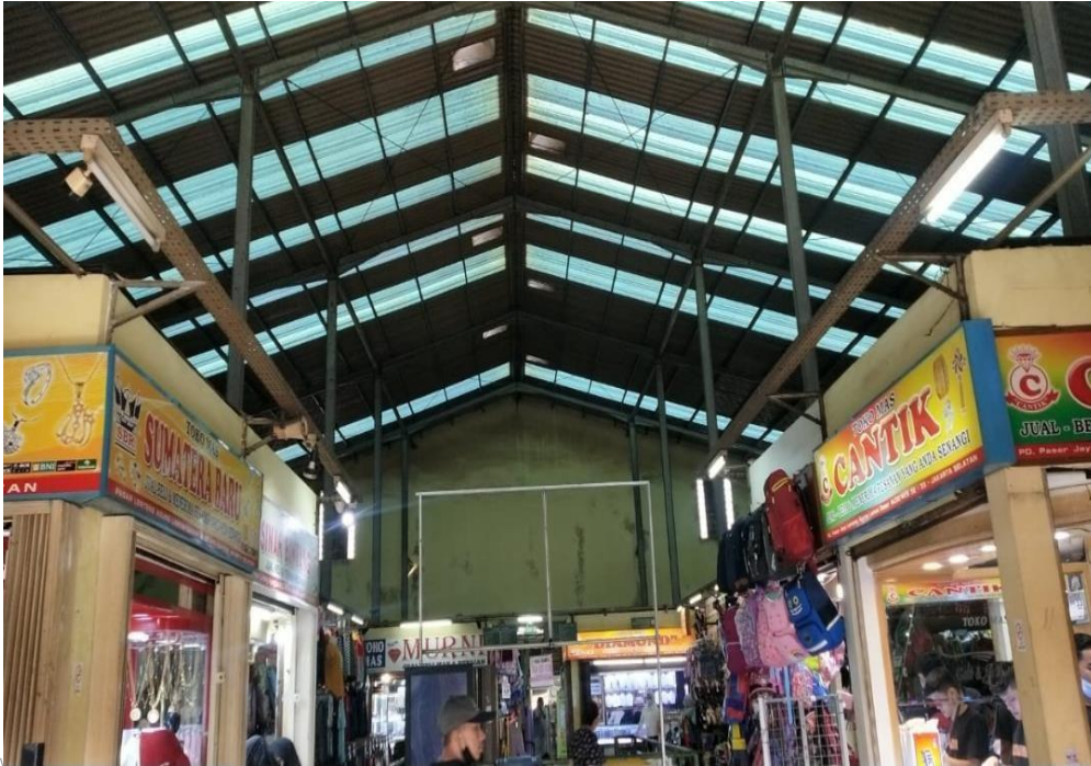
Gambar 17 Atap Gedung Pasar Lenteng Agung
