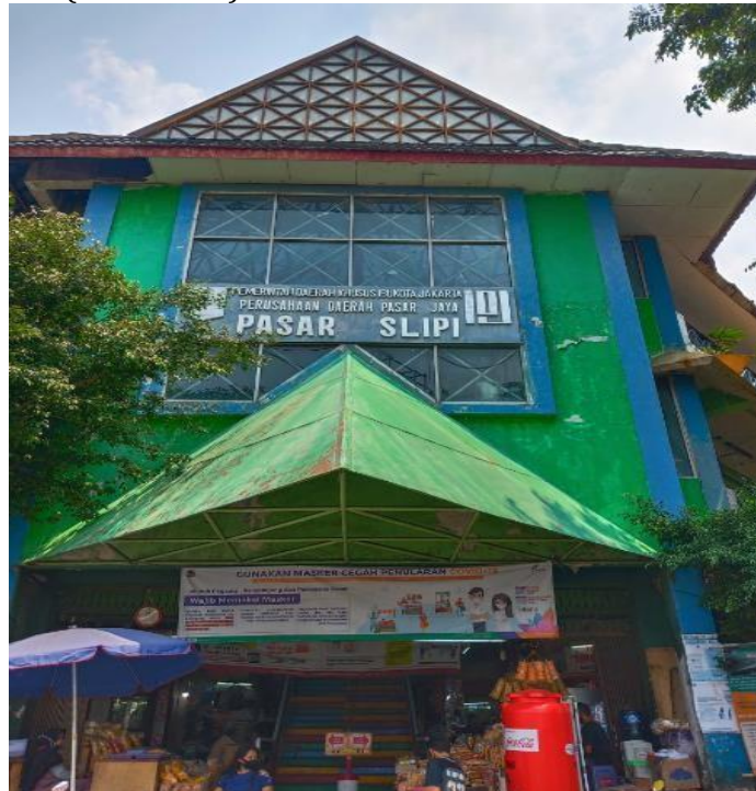
Gambar 21. Tampak Depan Gedung Pasar Slipi
