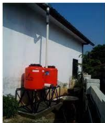
Gambar 4 Instalasi Pemanenan Air Hujan (Dinas Lingkungan Hidup Kota Semarang )
