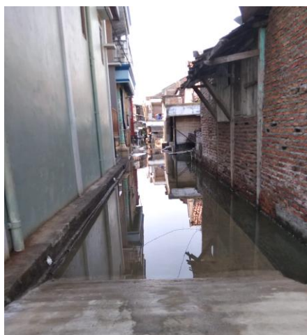
Gambar 4. Kondisi jalan yang tergenang rob (Dokumentasi Pribadi)
